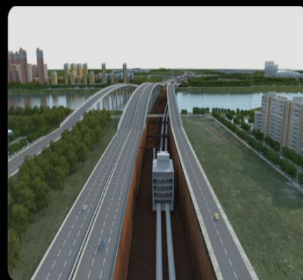
330KV线缆落地
