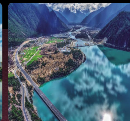
多布水电站G310旧桥改建工程
