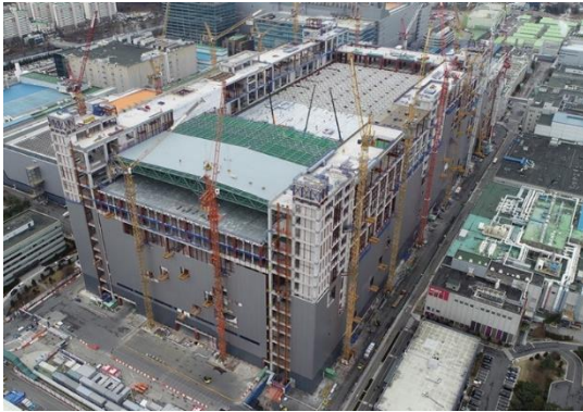
하이닉스 M16 Project 시공사진
