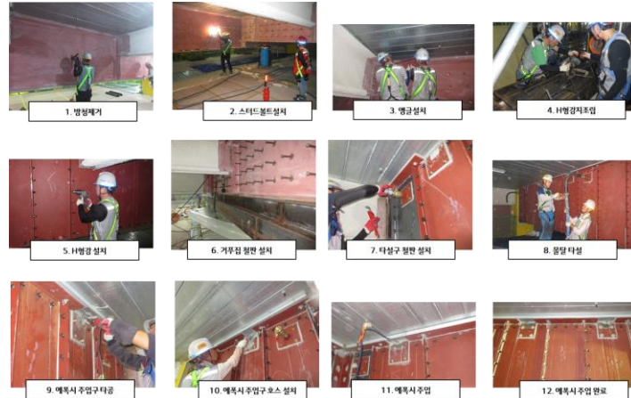
SRC 보강공사 (센코어테크)
